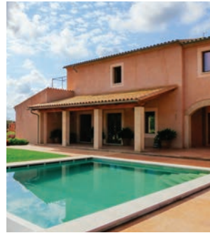
Passief gerenoveerde villa "Proyecto Tierra" in Lucmajor, Mallorca (Spanje)
